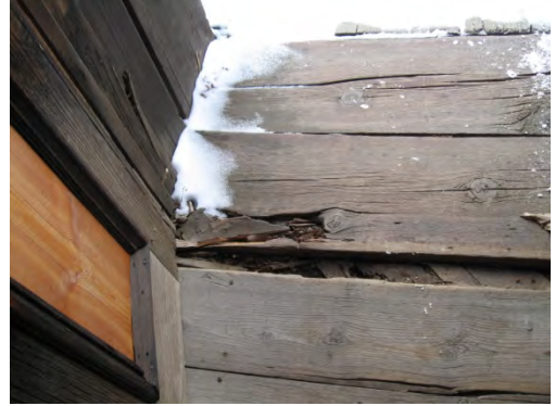
Rotten door threshold
